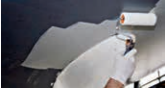
Apply antifouling over primer
