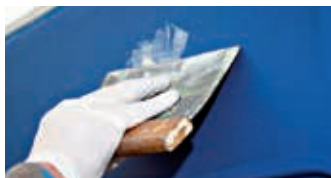
Fill using blade
