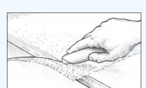
Abbilduna Schneiden überschüssiges Gewebe ab, wenn das Epoxidharz in den Geleezustand gewechselt hat, iedoch noch nicht ausgehärtet ist.
