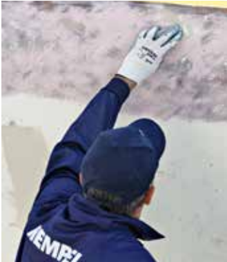
Spachteln entlang der Wasserlinie
