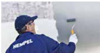
Auftragen von Hempel's Underwater Primer auf die vorbereitete Oberfläche
