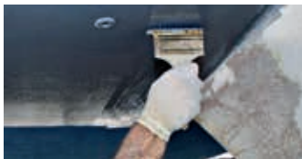
Hempel's High Protect II mit einem Pinsel in entgegengesetzter Richtung verschlichten
