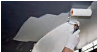
Antifouling auf Primer auftragen
