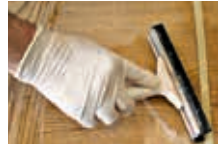
Verschmutztes Wasser entfernen
