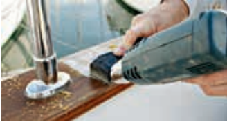
Alten Lack mit Heißluftpistole entfernen
